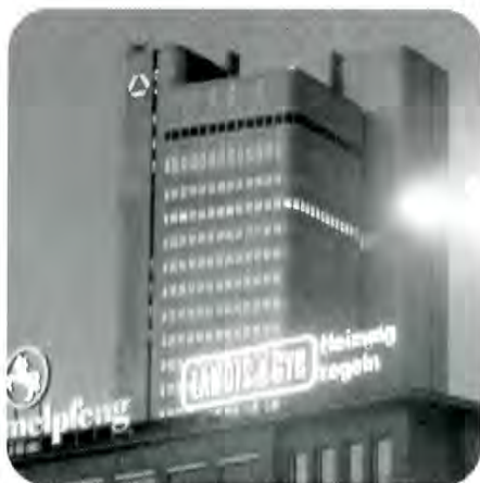
Heizungs- und Klimaregelung. Leittechnik
